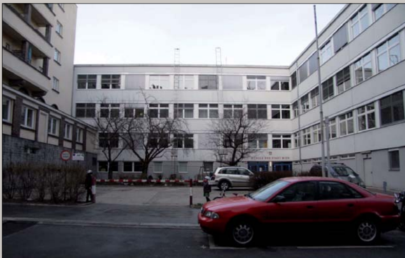
Bestandssituation vor der Schule
