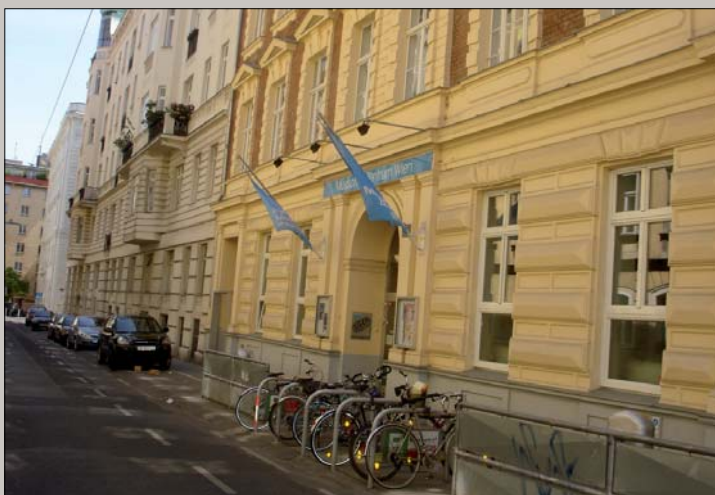
Bestandssituation vor der Schule
